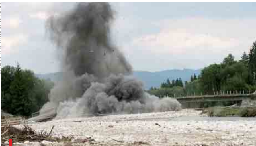
NOWA BIAŁA. Saperzy użyli do wysadzenia mostu 60 kg trotylu i plastikowego materiału wybuchowego. Wybuchy będą kontynuowane w kolejnych dniach, ale ich skala będzie znacznie mniejsza
