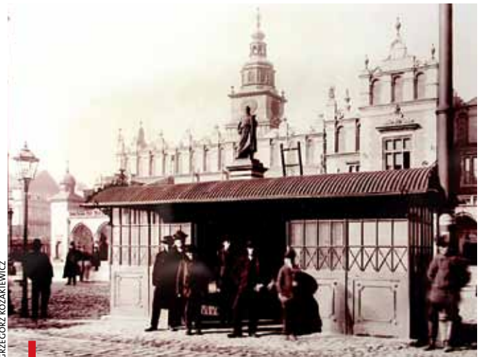
Poczekalnia przy przystanku tramwajowym w Ryнку Głównym, niedaleko pomnika A. Mickiewicza, 1910 – repr. fot. Antoniego Pawlikowskiego
