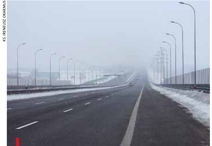
Początek wschodniej obwodnicy wygląda imponująco, ale budowa dalszej części tonie w mgłach niepewności...
