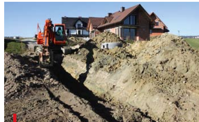
Zamiast nowej oczyszczalni mieszkańcy Podhala woleliby usłyszeć o inwestycjach związanych z kanalizacją. NA ZDJĘCIU budowa kanalizacji na nowotarskim osiedlu Niva. Mieszkańcy czekali na nią od czasów przedwojennych
