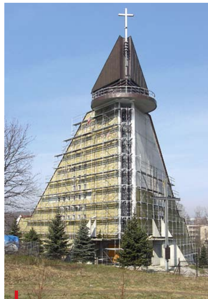
Na osiedlu Rżaka w kościele pw. Nawiedzenia MNP wierni będą się modlić w 2010 roku
