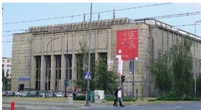
Gmach główny Muzeum Narodowego w Krakowie ma być w niedalekiej przyszłości modernizowany
