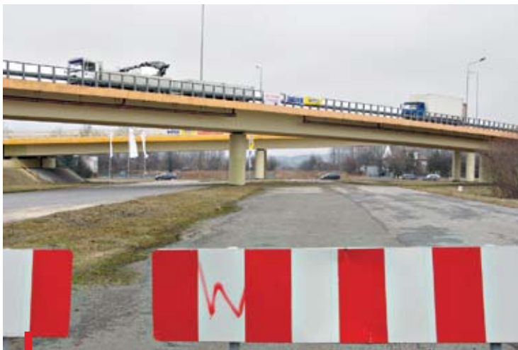
W chwili obecnej na rondzie Radzikowskiego kończy się północna część obwodnicy Krakowa. Za dwa lata będzie ona dłuższa o 2,5 km
