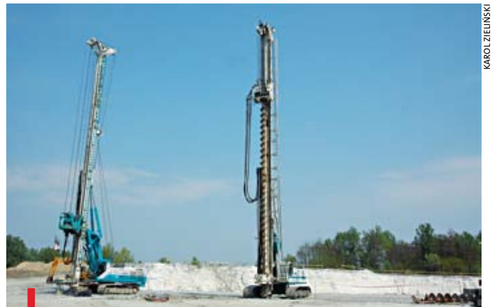
Za pomocą takich maszyn zostanie wywierconych 299 otworów o głębokości 25 metrów
