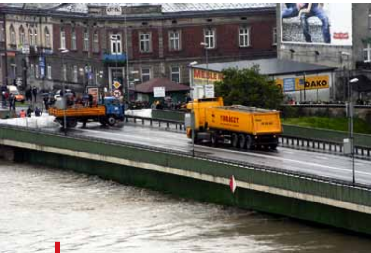
Woda zalała filary mostu Dębnickiego. Na końcu mostu widać białą zaporę, mającą chronić ulice przed wylaniem się wezbranej wody
