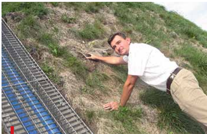
Leszek Cierpiałowski prezentuje szkody spowodowane przez wodę: odspojenia i osunięcia się ziemi, które odsoniły liny utrzymujące ziemną konstrukcję
